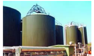
Tanques de mezclado, pasteurización y digestores.
